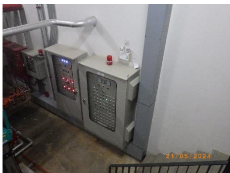
รูปที่ 2-17 ระบบมอเตอร์ไฟฟ้าสำหรับ ระบบบำบัดน้ำเสียของโครงการ
