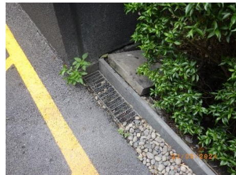
รูปที่ 2-63 ตะแกรงครอบท่อระบายน้ำ
