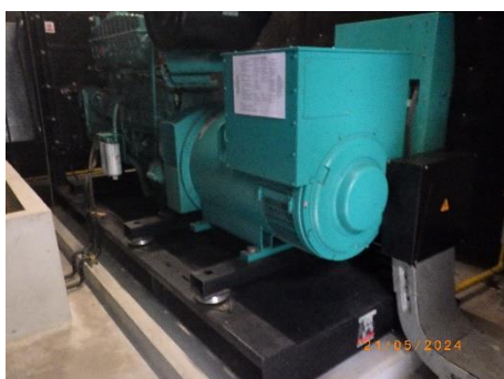
รูปที่ 2-42 เครื่องกำเนิด ไฟฟ้า 300 KVA
