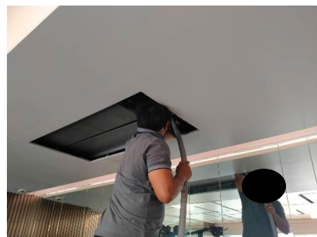
รูปที่ 2-35 การล้างแผ่นกรองอากาศของ เครื่องปรับอากาศ
