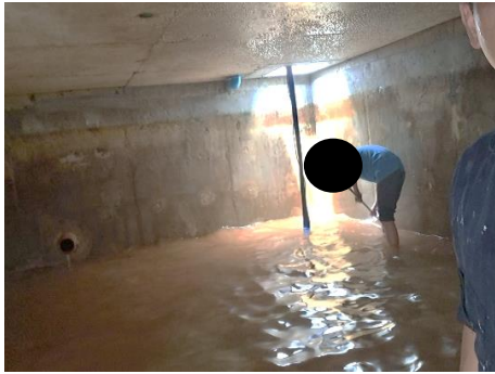
รูปที่ 2-24 การล้างทำความสะอาดถึงเก็บน้ำสำรอง
