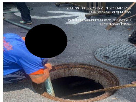
รูปที่ 2-12 การสูบน้ำจากตะกอน
