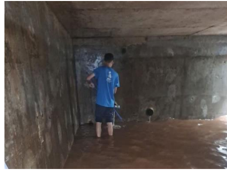
รูปที่ 2-24 การล้างทำความสะอาดถึงเก็บน้ำสำรอง
