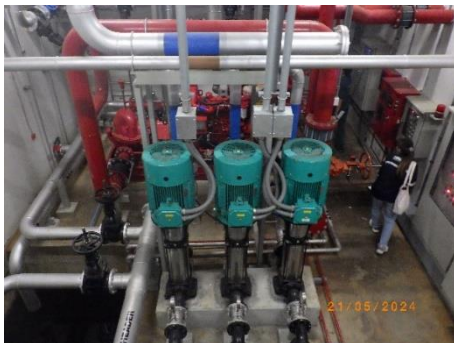
รูปที่ 2-20 ระบบสูบน้ำภายในอาคาร
